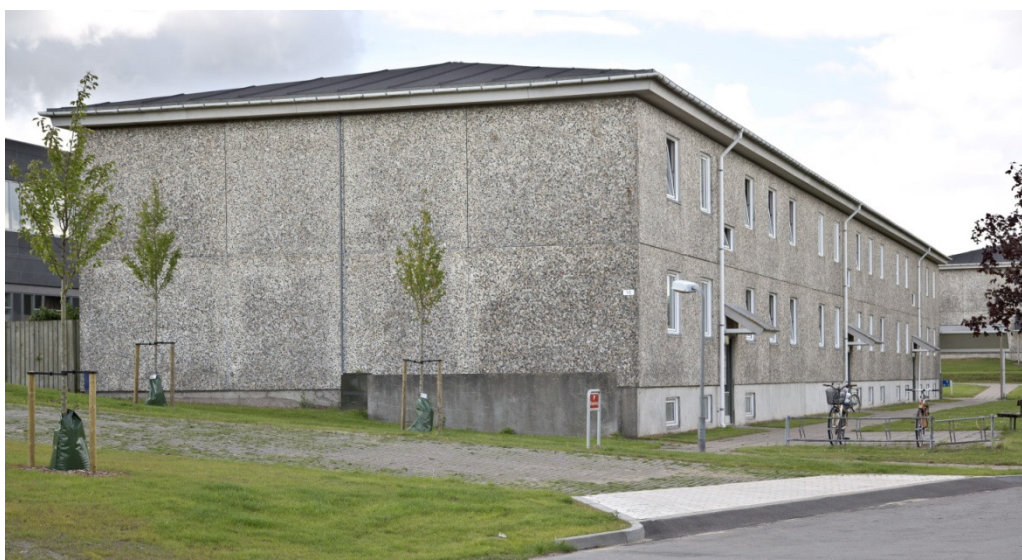
Blokkene i Kildeparken er 40 år gamle og med stort behov for fornyelse, på både Fyrkildevej, Blåkildevej og Ravnkildevej
