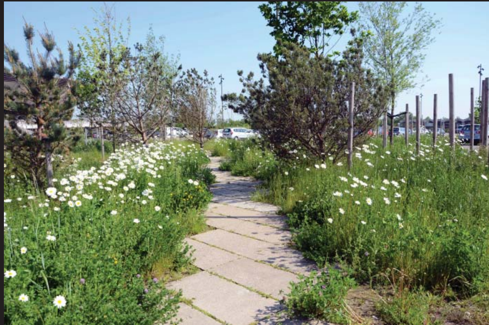
Regnbed med betonflise sti - Nyt Herlev Hospital, SLA
